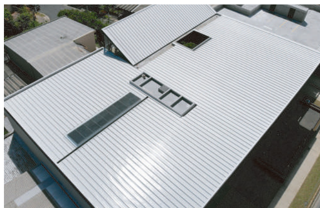
OFICINAS SPACTIUM, ORG, SANTA TECLA
